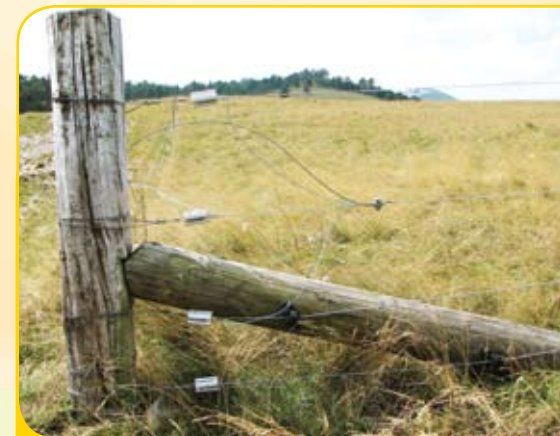
Napenjalni kol je osnova trpežne in učinkovite stalne večžične elektroograje. Biti mora močan in čvrsto postavljen, saj mora vzdržati veliko silo dobro napetih žic. Napenjalni koli morajo stati ob vratih in na ostrih spremembah smeri ograje.
