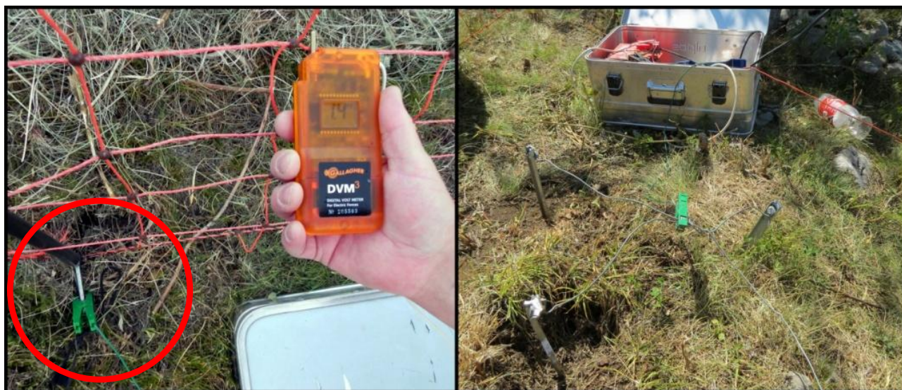
Slika 5: Primer neustrezne (levo) in ustrezne (desno) ozemljitve pašnega aparata
